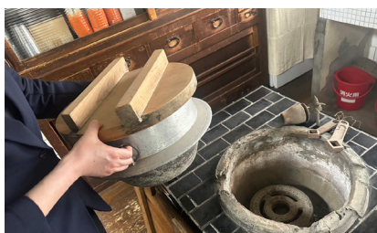
釜の下に配置された五徳(ごどく)。床下からのガス管と接続されている。
