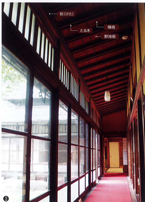
和室2:南側の入側天井
