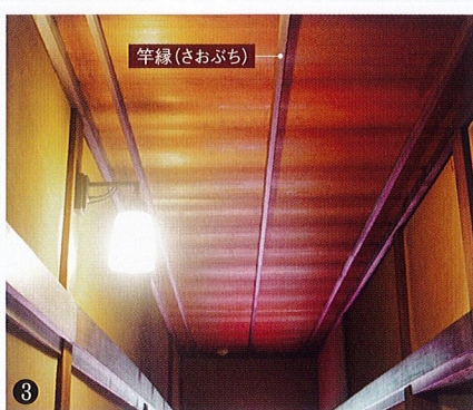
和室1:北側トイレまでの天井
