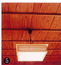
和室1:次間(二之間)の天井
